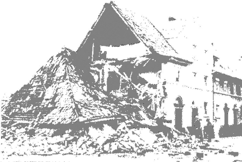
Typisch sind hier die homogenen Trümmer des Massivmauerwerks der beiden unteren Geschosse und das im wesentlichen auch nach dem Zusammenbruch erhaltene Dach als Skelettkonstruktion mit großen Hohlräumen.
